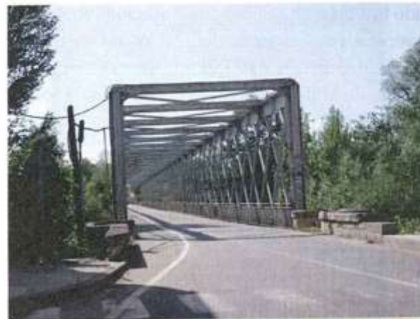
Puente de hierro.
