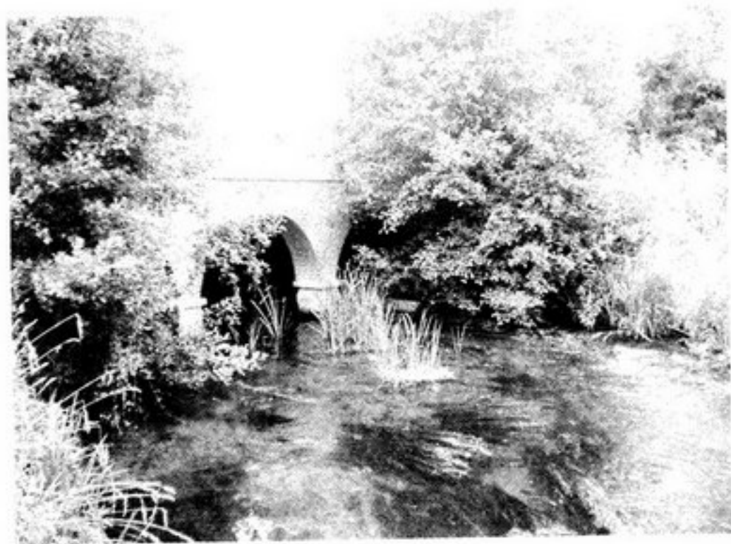
Detalle de los restos de un molino cerca de Alcoba de la Ribera. Se pueden apreciar los arcos de piedra y ladrillo, y las paredes de tapial.
